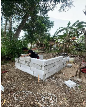
Gambar 4 pemasangan dinding tempat pembakaran sampah
