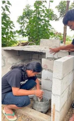
Gambar 6 proses pembuatan pintu tempat pembakaran sampah
